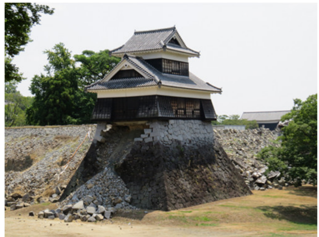
Beim Erdbeben wurden viele Mauern wie hier beschädigt.
